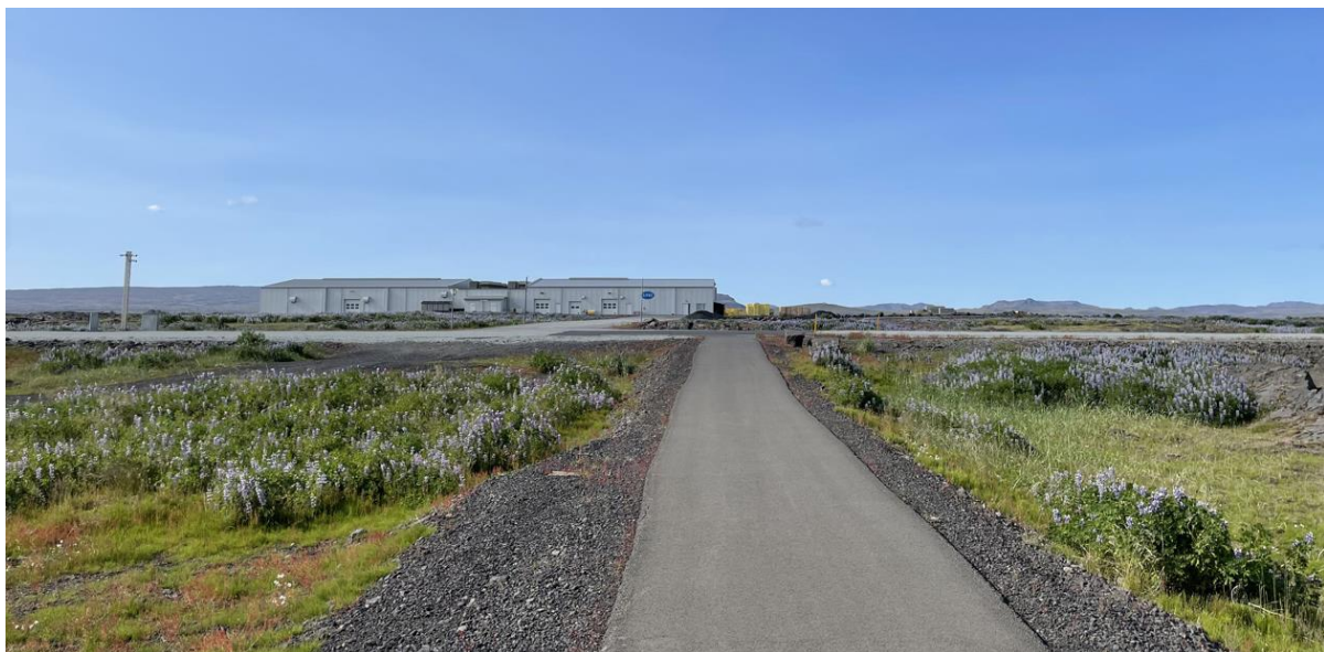
Mynd 7.2 Bygging LÝSIS hf. við Suðurstrandarveg. Sjá má hvar göngu- og hjólastígur endar við Suðurstrandarveg til móts við bygginguna.
