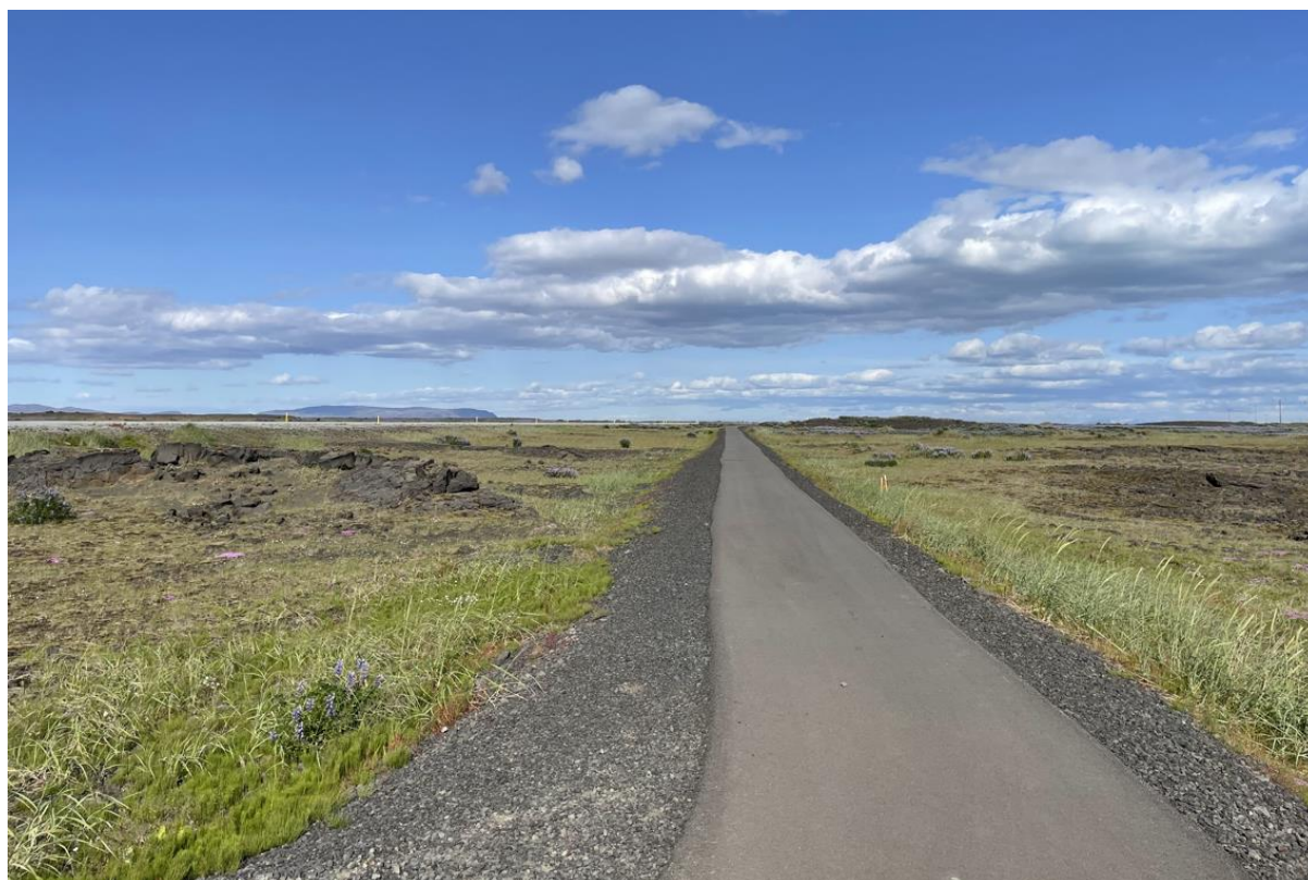
Mynd 7.21 Göngu- og hjólastígur meðfram Suðurstrandarvegi.
