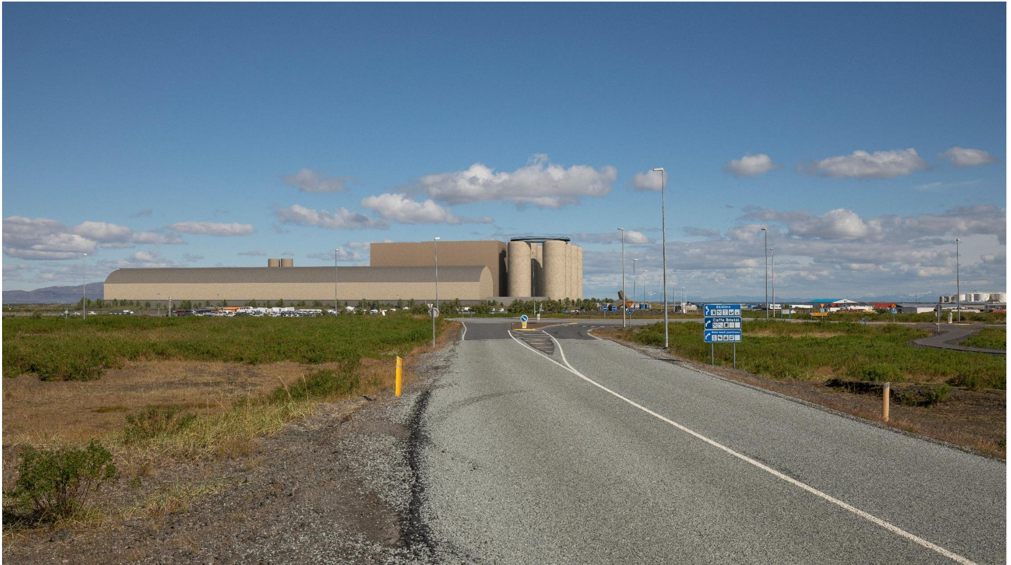
Möguleg ásynd fyrsta og annars áfanga við gatnamót Suðurstrandarvegjar og Þorlákshafnarvegjar. Horft í austur í rúmlega 500 m fjarlægð.
