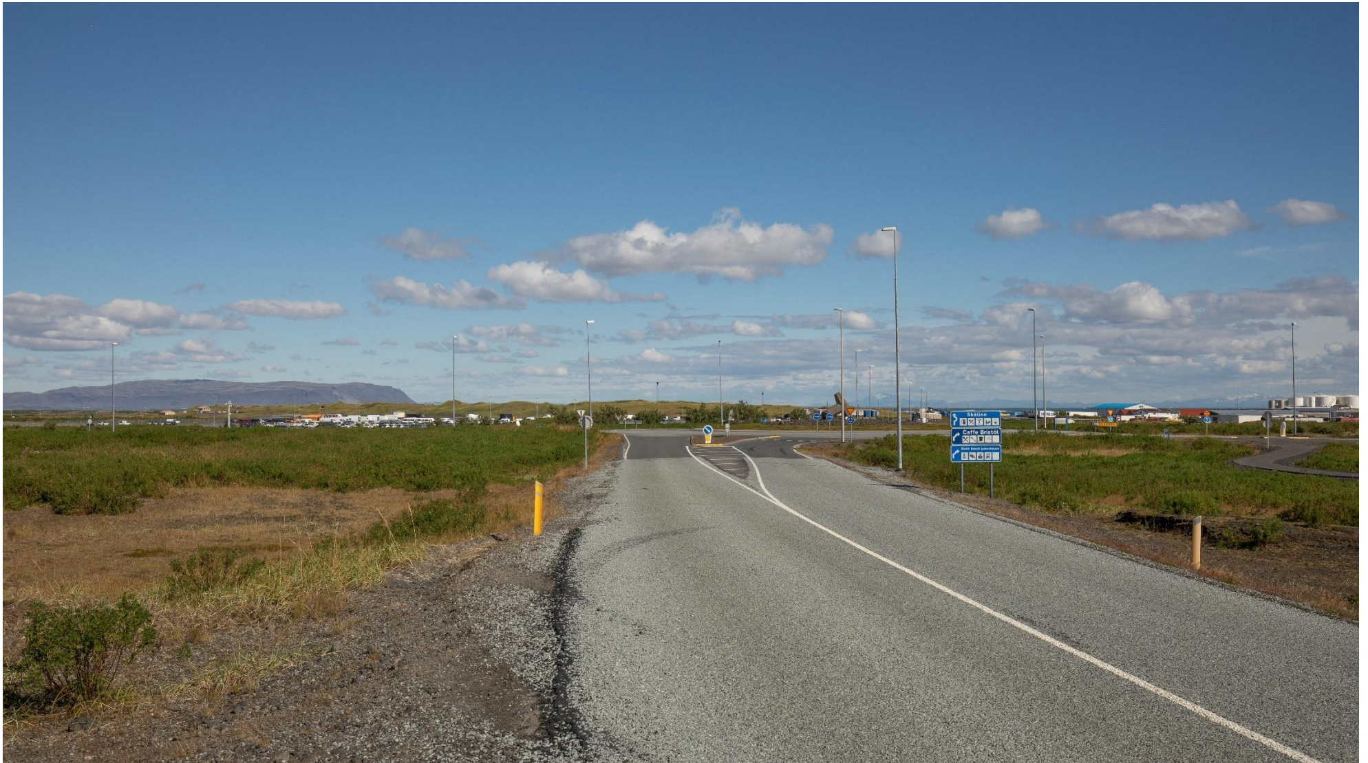
Núverandi ásjón við gatnamót Suðurstrandarvegjar og Þorlákshafnarvegjar. Horft í austur.
