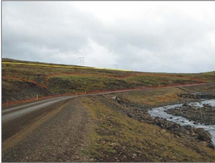
Mynd 4.2.5. Séð framan á holtið. Veglínan er ofan við námuna og er nálægt Byggðalínu Rarik. Núverandi vegur nýttist sem námuvegur (Ljósmynd: Hafdís Eygló Jónsdóttir).
