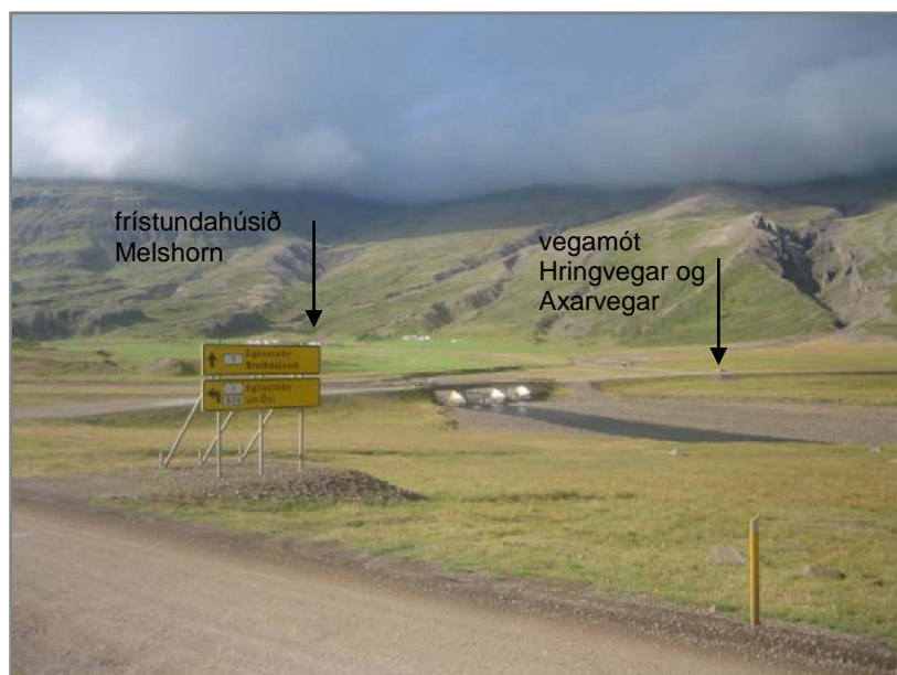
Mynd 2.2.9. Brú yfir Berufjarðará á Hringvegi við vegamót Axarvegur (Ljósmynd: Helga Aðalgeirsdóttir, 2008)
